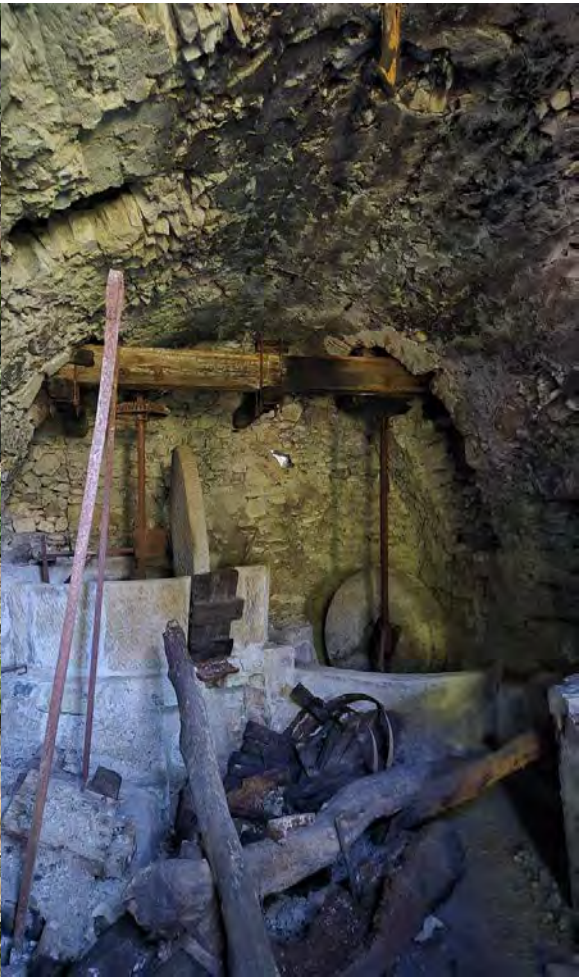
Intérieur du moulin sur la route vers Libre
