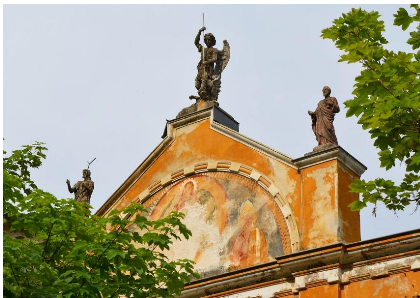
Vue du fronton en 2019. (Cliché © Patricia Balandier)
