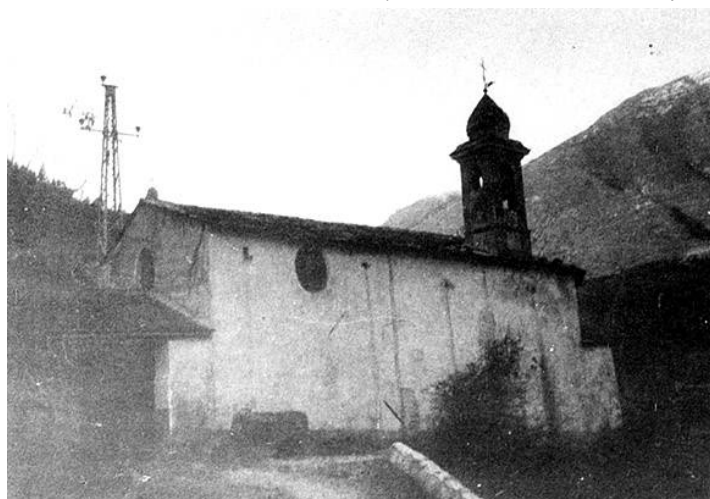
Photo montrant le porche avant 1960. (Collection Monuments historiques, Fonds Bercé – CRMH)
