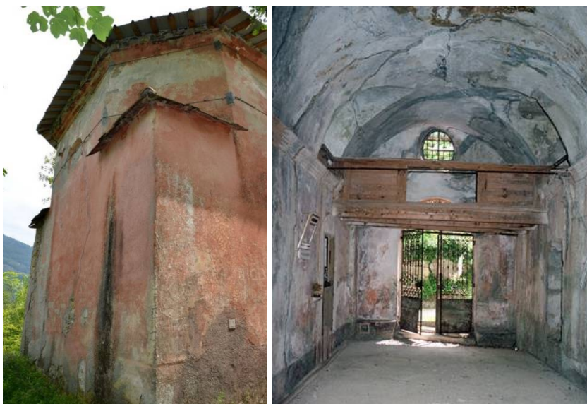
Vue du chevet plat à la base, et à pans coupés en hauteur. (cliché © Patricia Balandier)
