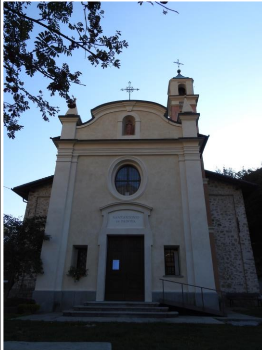
Sant'Antonio da Padova: la facciata.
