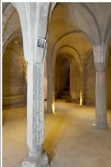
Chiesa parrocchiale di San Dalmazzo: il riuso dei materiali all'interno della cripta.
