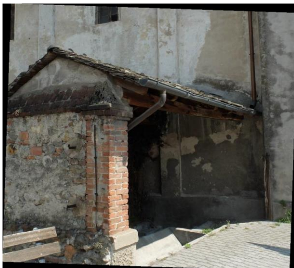
Lavatoio di via Boves/via Vittorio Veneto.
