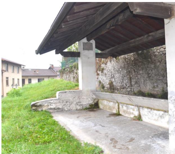
Lavatoio di Via Roma.
