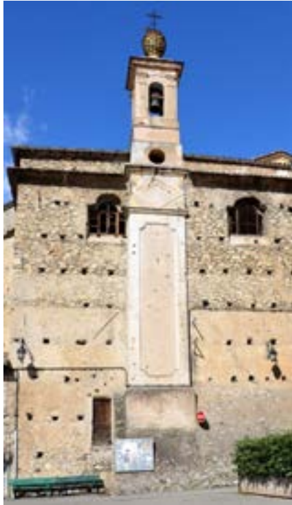
Vue du clocheton sur la façade sud. (Cliché © Patricia Balandier)
