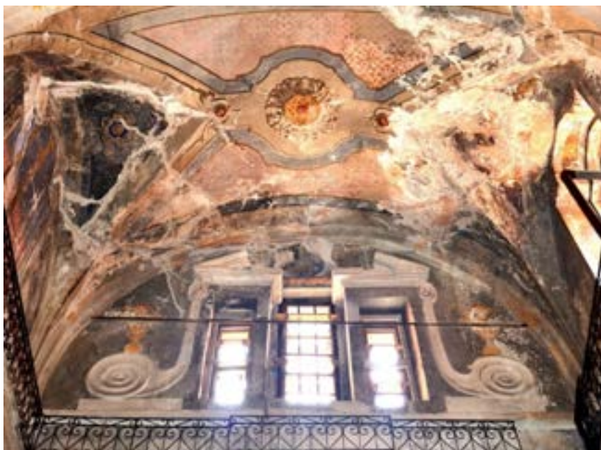
Encadrement de fenêtre à l'arrière de la façade principale par des ailerons à volutes en stuc du XVIIIe siècle, et décors de voûte XIXe siècle. (Cliché © Patricia Balandier)
