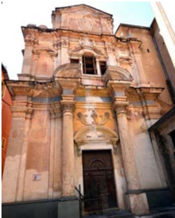
Façade de la chapelle de la Miséricorde, renforcée mais non restaurée. (Cliché © Patricia Balandier)
