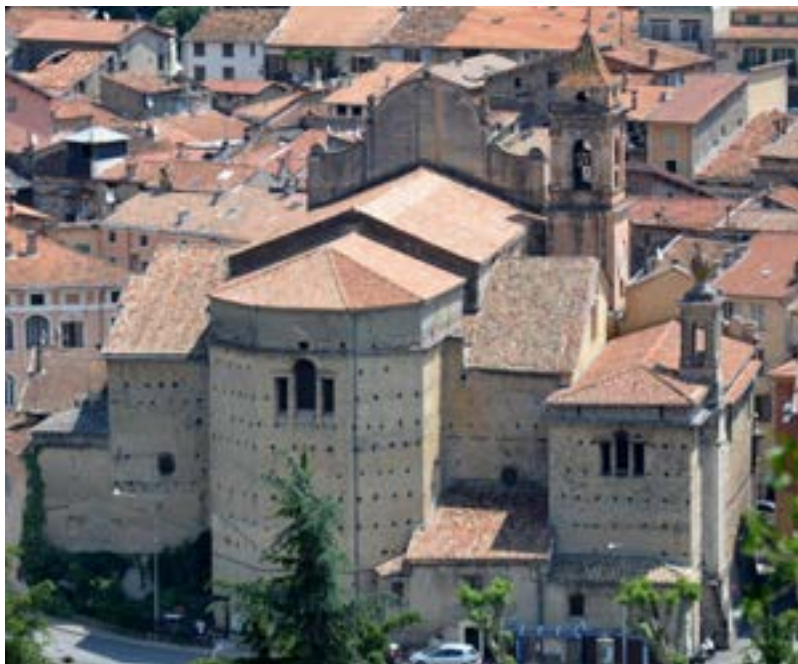
Vue des toitures et du chevet de l'îlot de l'église depuis l'ouest. (Cliché © Patricia Balandier)
