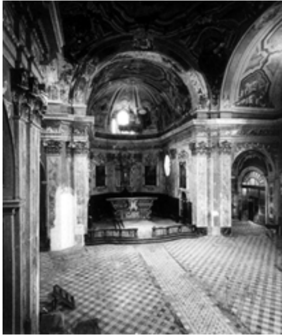
Vue de l'église pendant la fermeture pour travaux (avant 1983) (© DRAC PACA)
