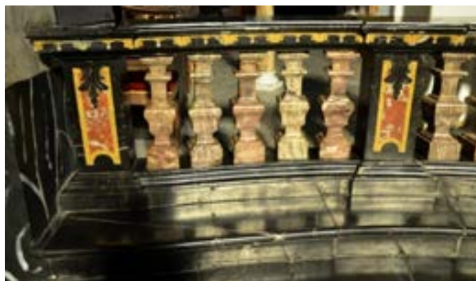
Vue de la table de communion, d'un modèle fréquent entre Nice et Torino, et des marches du chœur de l'église Santa-Maria in Albis, utilisant le marbre noir du Picaron. (cliché © Patricia Balandier)
