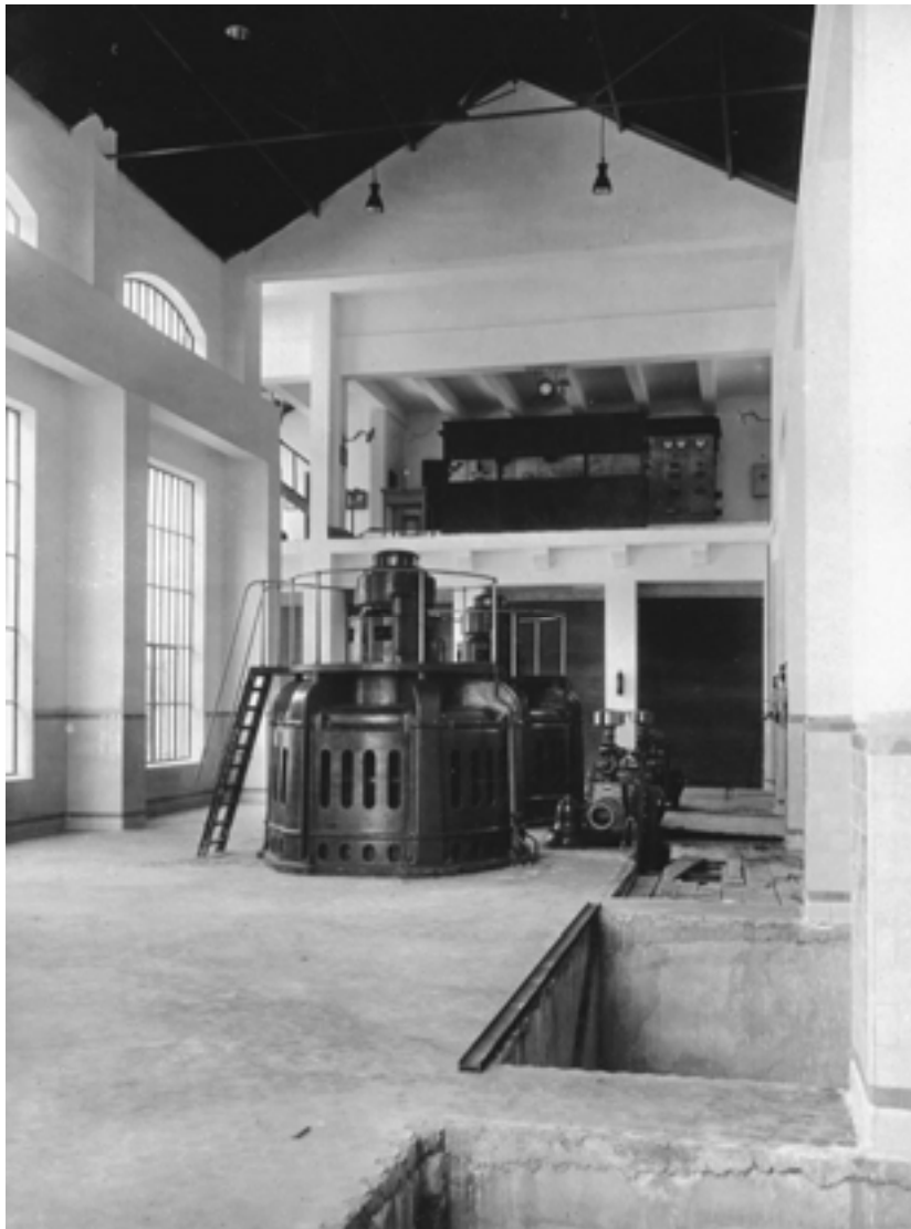
Salle des turbines (1926) (Collection JL Taylor, cliché © Giletta)
