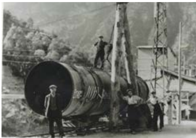
Conduite en chantier (1926) (Collection JL Taylor, cliché © Giletta)
