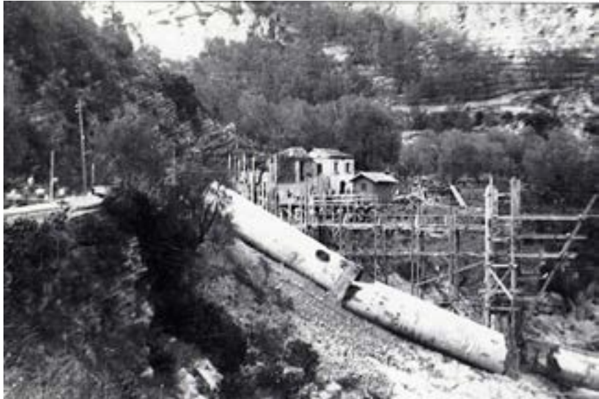
Conduite détruite en 1940. (Magazine Le Haut-Pays)
