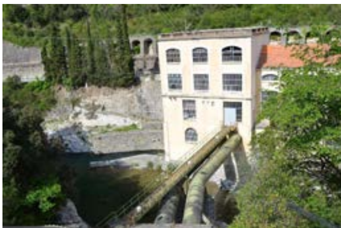
Vue de la conduite forcée franchissant la Roya pour entrer dans la centrale (cliché © Patricia Balandier)
