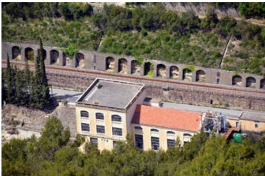
Vue plongeante sur la centrale construite en contrebas de la voie ferrée et de la route. (cliché © Patricia Balandier)
