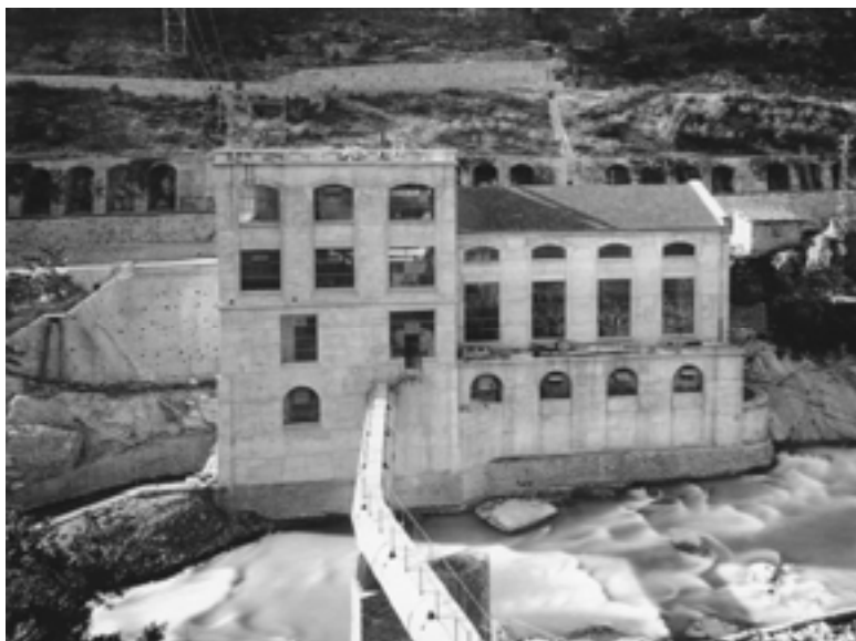
Centrale en chantier (1926) (Collection JL Taylor, cliché © Giletta)
