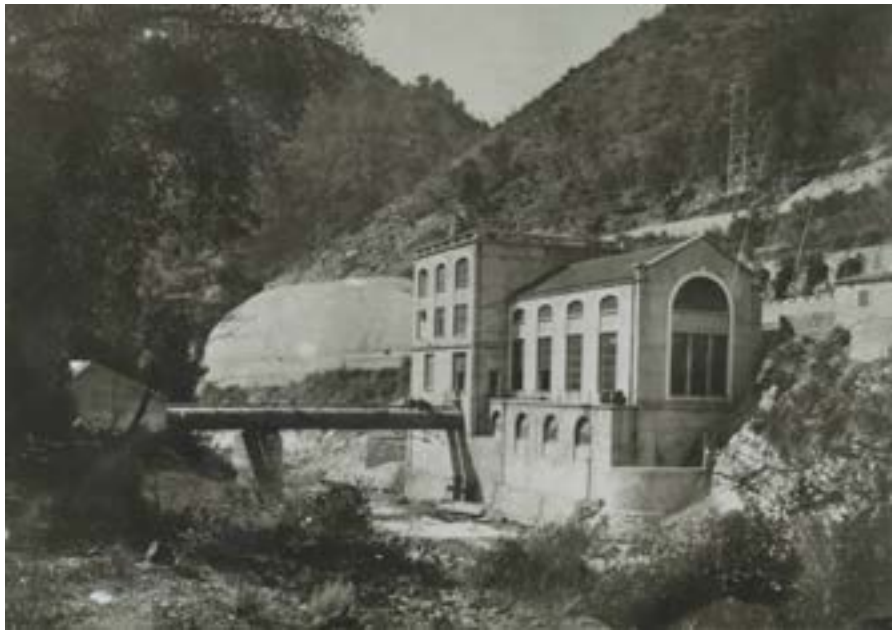
Centrale achevée (1926) (Collection JL Taylor, cliché © Giletta)
