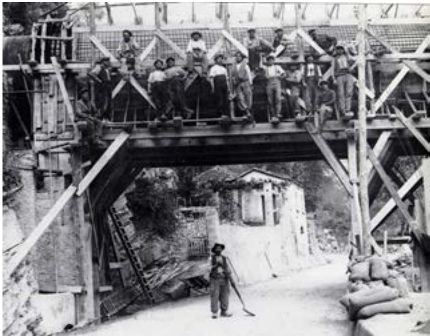
Chantier de 1926. (Magazine Le Haut-Pays)
