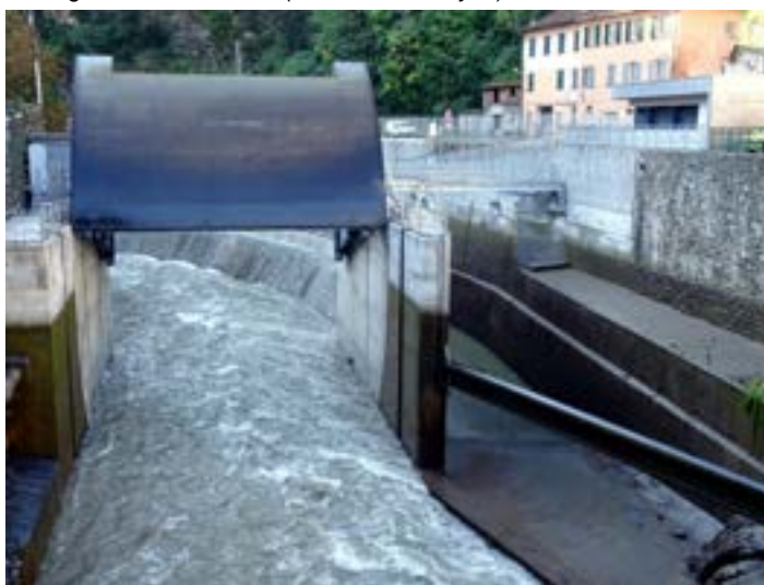
Vue de la nouvelle vanne ouverte pendant la crue de la Roya du 4 octobre 2015 (cliché © Patricia Balandier)
