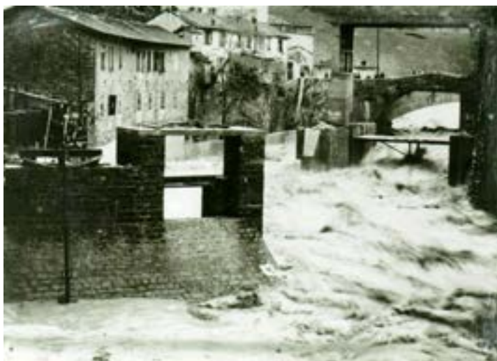
Crue de 1926, pendant le chantier. (Collection JL Taylor)
