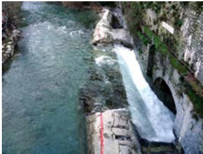
Vue du barrage volontairement abaissé pour réduire le niveau d'eau dans la Roya pendant le chantier de remplacement de la vanne du lac. (cliché © Patricia Balandier)
