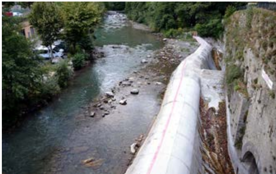
Vue du barrage écrêteur de crue, des deux avaloirs et de l'entrée des tunnels en période d'étiage. (cliché © Patricia Balandier)
