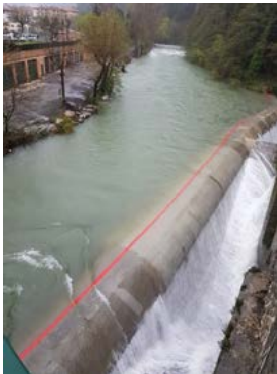
Vue du barrage et des avaloirs pendant une montée des eaux. (cliché © André Ipert)
