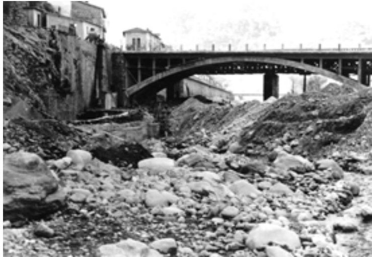
Travaux de réparation du barrage en décembre 1951. (Collection JL Taylor)
