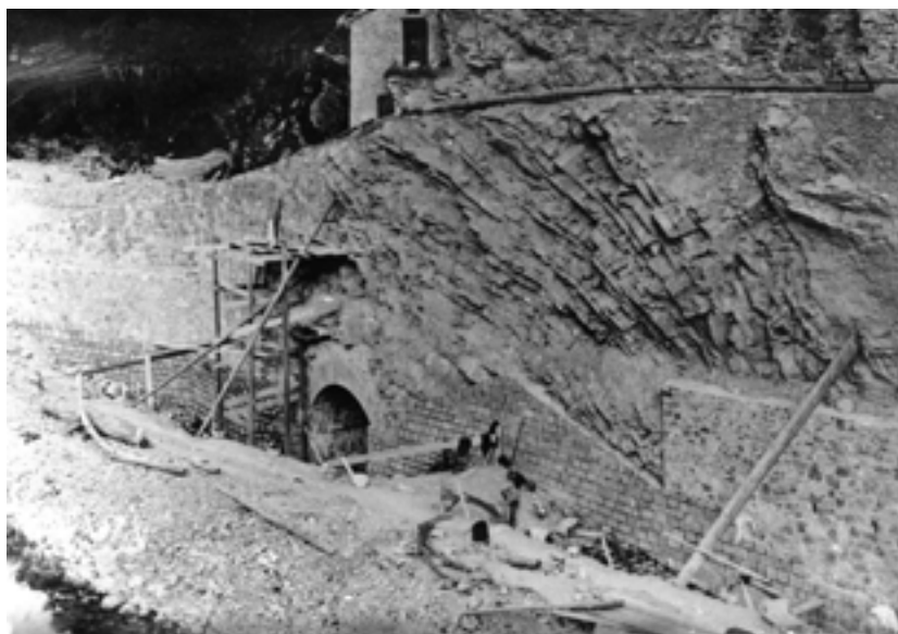
Chantier à l'entrée de l'évacuateur de crues en juillet 1930. (Collection JL Taylor)
