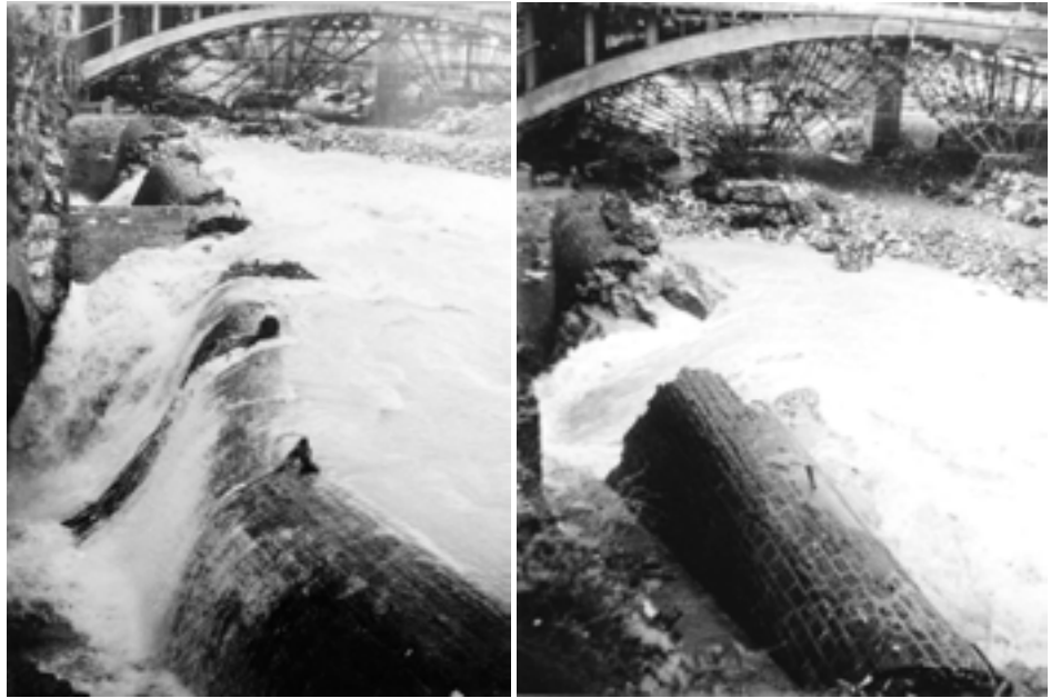
Crue destructrice en novembre 1951. Le barrage maçonné a cédé. (Collection JL Taylor)
