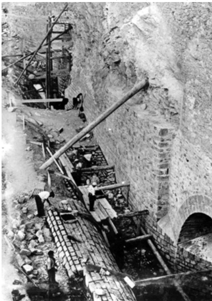
Chantier à l'entrée de l'évacuateur de crues en juillet 1930. (Collection JL Taylor)
