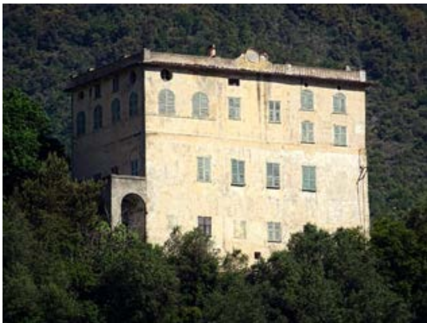
Vue de la façade sud du Château Cachiardi de Montfleury. (cliché © Patricia Balandier)
