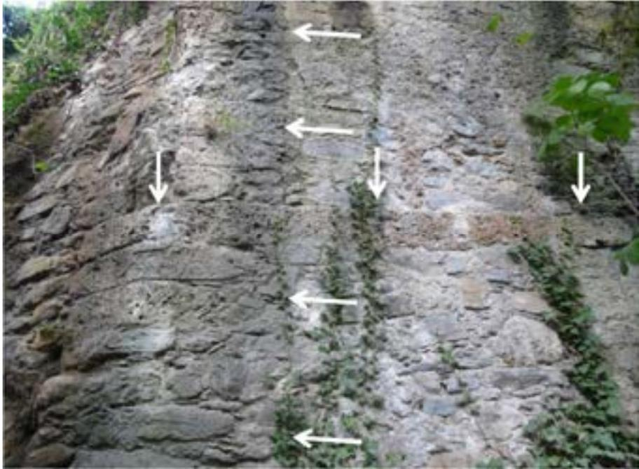
Vue des éléments structurants de la culée ouest : chaînes maçonneries latérales et horizontale. (Cliché © Patricia Balandier)
