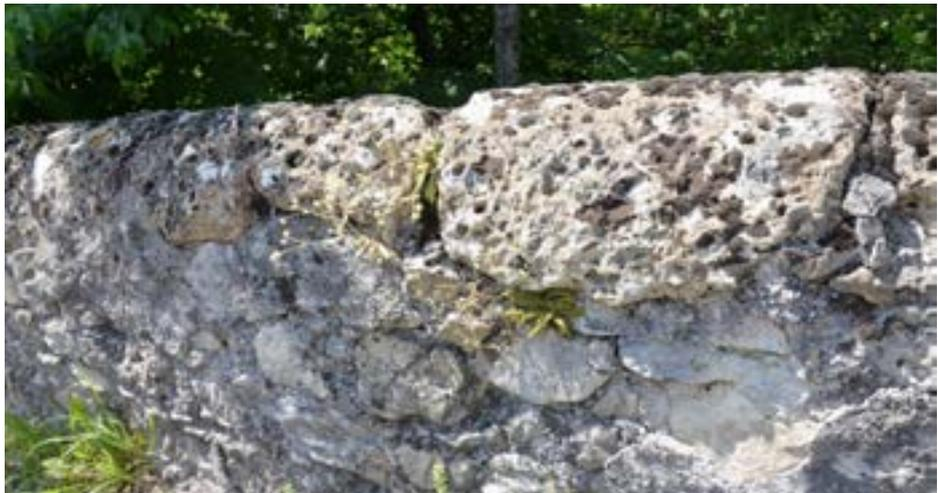
Vue de détail des pierres de couverture du parapet en cargneule, taillées en demi-cylindres. (Cliché © Patricia Balandier)
