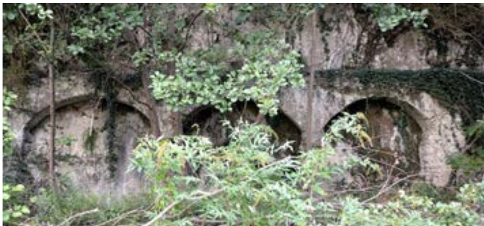
Vue partielle du Canal plus au sud, au dessus d'une plage de la Roya. Les arcades ne reposent plus sur des corbeaux ancrés dans la roche, mais sur des pilastres fondés dans le sol. (cliché © Patricia Balandier)
