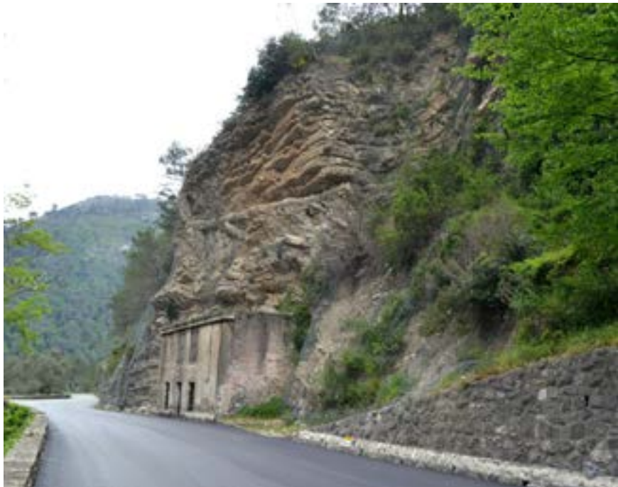
Tronçon du canal de Ravaï face au pont médiéval de Ravaï. (cliché © Patricia Balandier)
