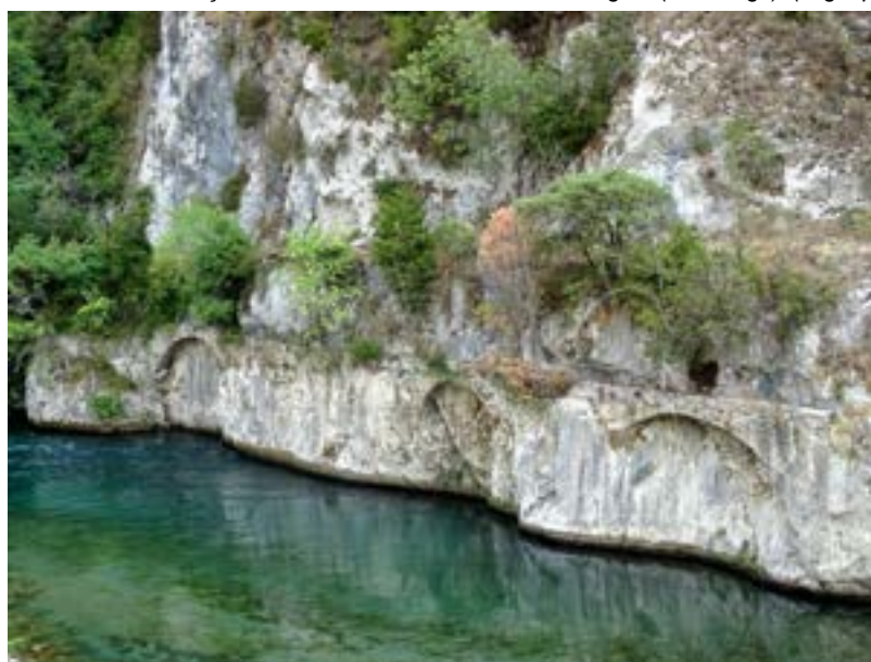
Vue du tronçon en encorbellement sur arcades du canal de l'Aïgara en rive gauche de la Roya. Un chemin communal aménagé dans la falaise passe juste au dessus. (cliché © Patricia Balandier)
