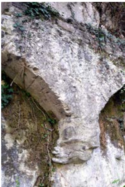
Détail d'arcs reposant sur un corbeau ancré dans la falaise. (cliché © Patricia Balandier)
