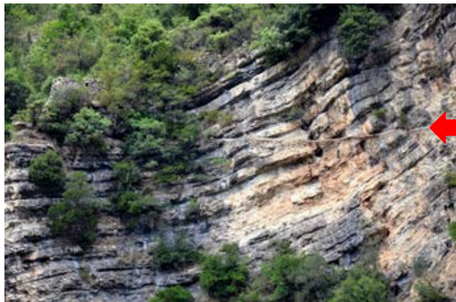
Vue de la partie ouest du canal du Casté dans la falaise. (cliché © Patricia Balandier)
