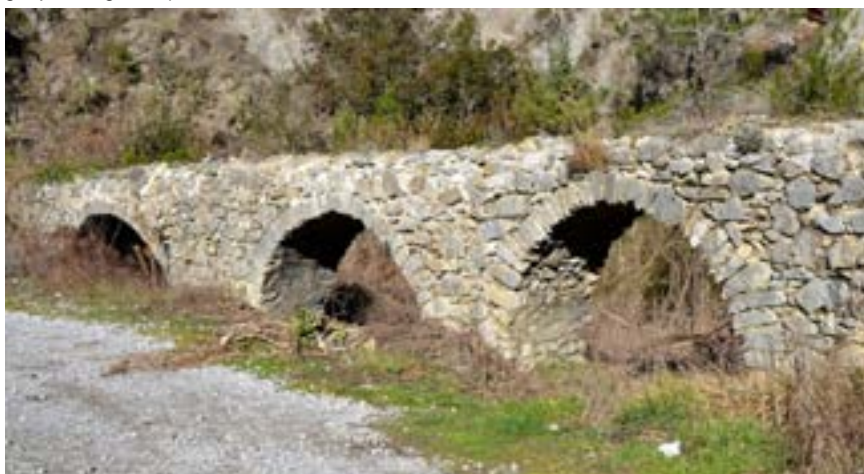
Pont-siphon de Piène-Haute. (cliché © Patricia Balandier)
