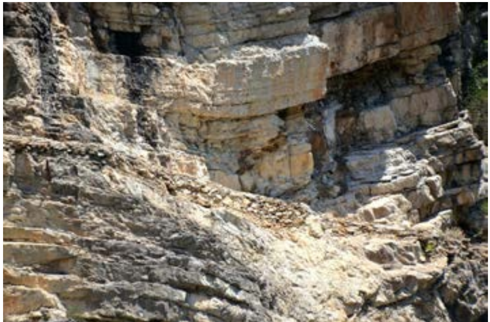
Vue rapprochée d'un tronçon du canal du Casté dans la falaise de la porte de Gènes.. (cliché © Patricia Balandier)
