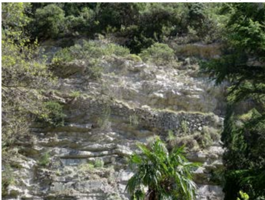
Tronçon du canal de Ravaï à l'arrière de la chapelle de Piène-Basse. (cliché © Patricia Balandier)
