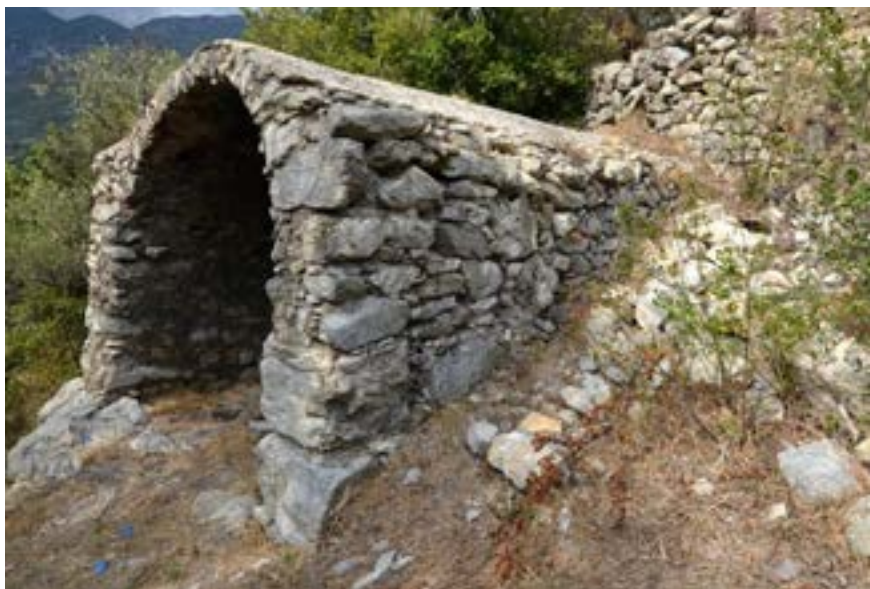
Exemple de configuration d'une croté utilisant le relief et la roche. (cliché © Patricia Balandier)
