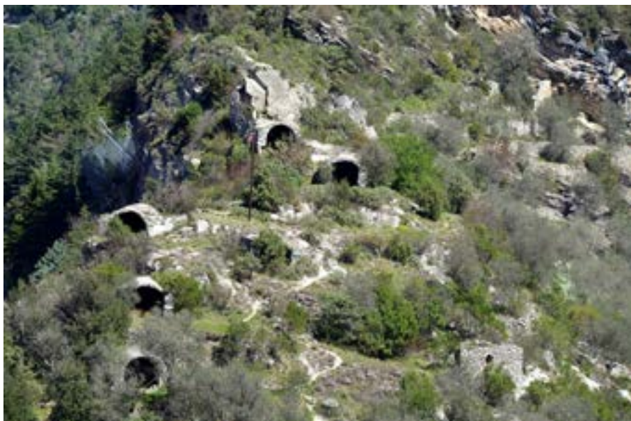
Vue actuelle du site du château et des crotés depuis le sud. (cliché © Patricia Balandier)
