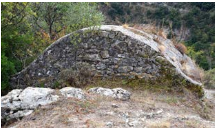
Exemple de configuration d'une croté utilisant le relief et la roche. (cliché © Patricia Balandier)
